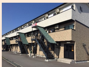
新設した外国人専用の寮（外観）
